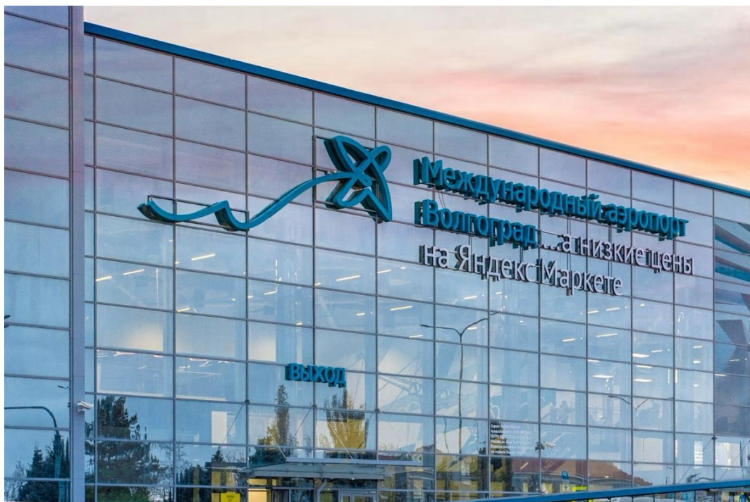
Рис. 2 - Реклама на фасаде Аэропорта
